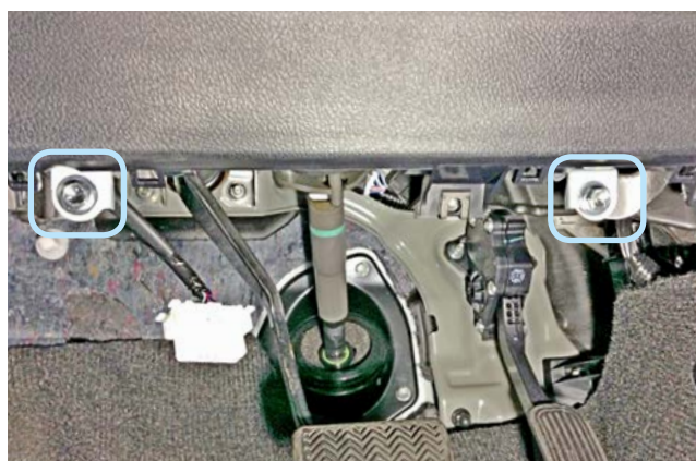
Фото 1.16. Болты крепления подушки безопасности снизу
