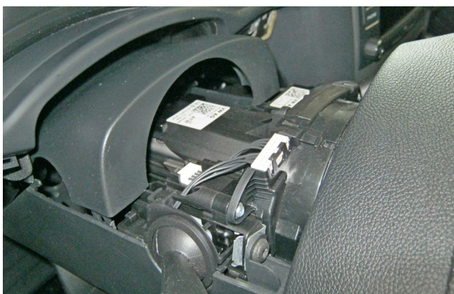
Фото 1.8. Верхняя часть кожуха снята
