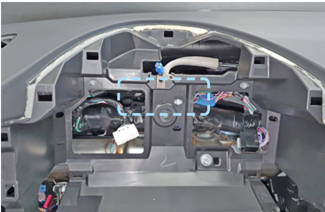
Фото 2.7. Пример расположения центрального блока охранно-телематического комплекса
